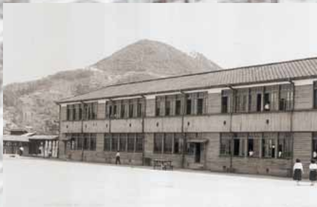
元広島市立工業専門学校校舎（広島市東雲町・昭和26年頃）
