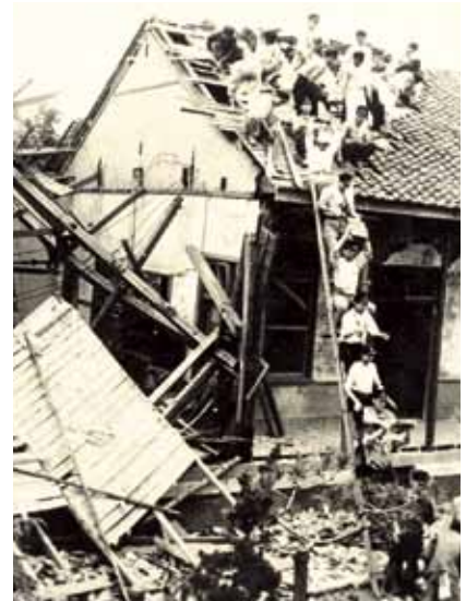
被爆後の復旧作業 (広島工業専門学校)
