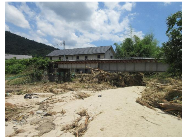
右岸側アパートへの氾濫
