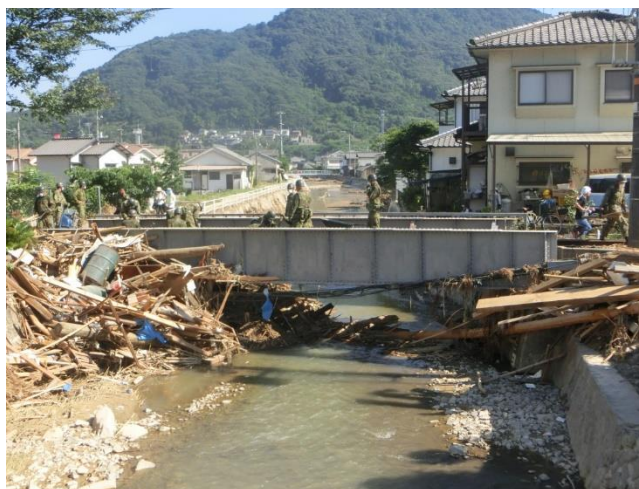
安浦駅周辺での橋梁による流水障害と内水氾濫
