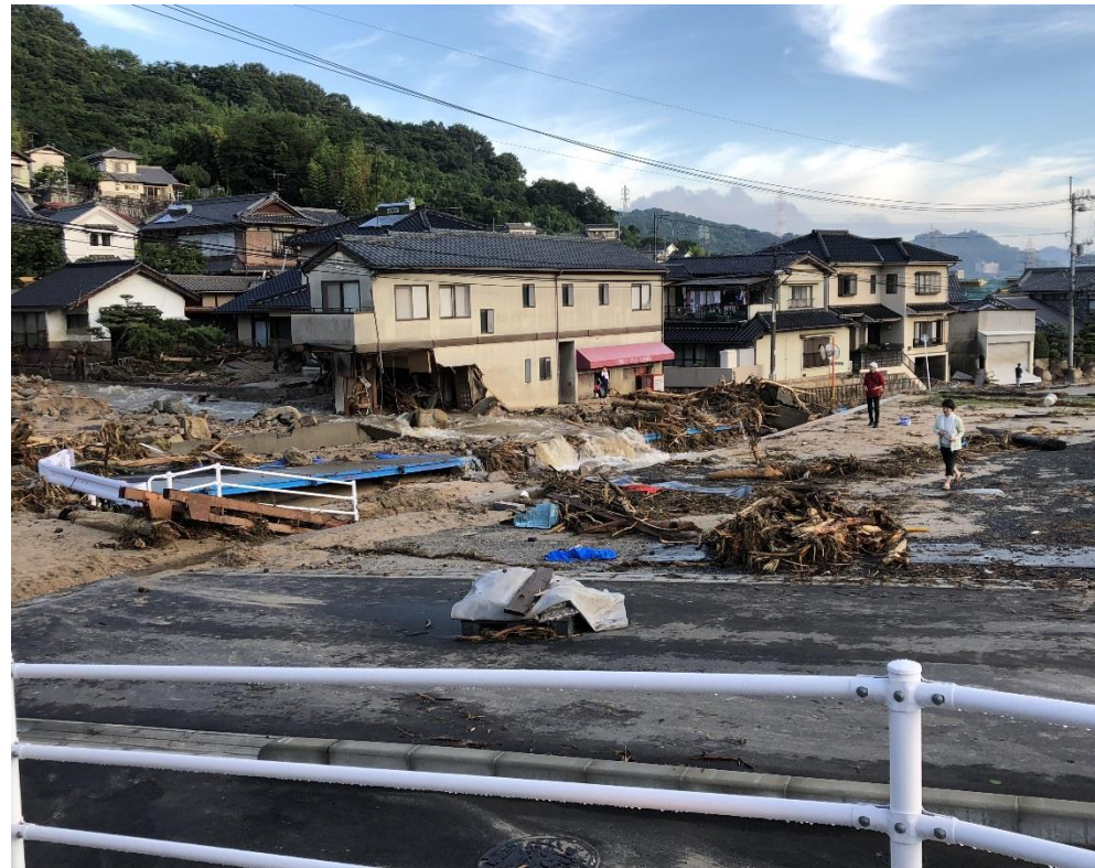
土石流が流れた後の河川 ▶ (総頭川中流域)
