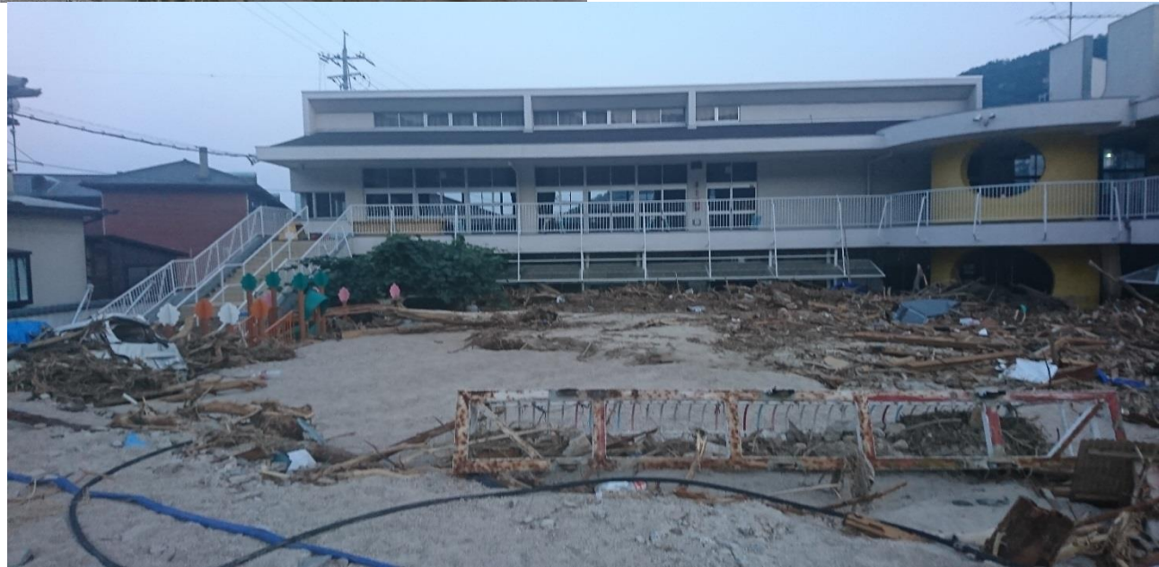
土砂や流木が流入 ▶ (小屋浦みみょう保育園)
