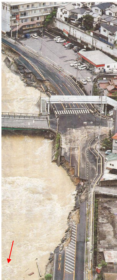
国道2号線の被災
