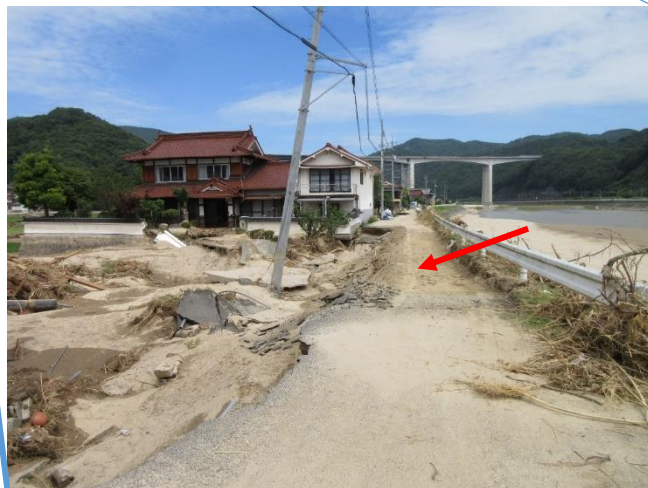
船木大橋上流部 左岸における越 流と侵食。
