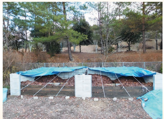
設置した堆肥場
