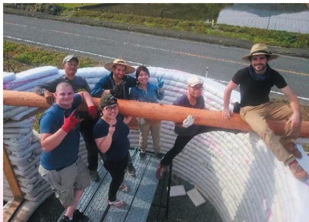
アースバッグハウスの屋根作りの様子
