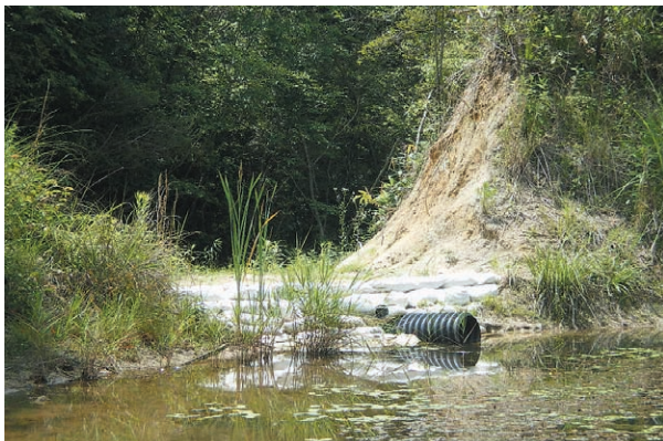
ため池保全のための堰堤補修工事
