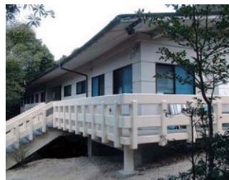
施設外観(本館)
