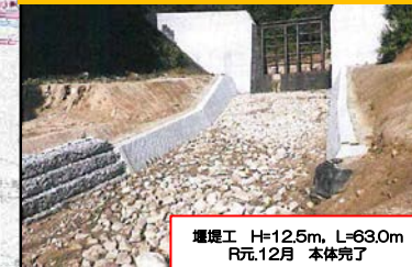
天地川【下流堰堤】(安芸郡坂町小屋浦4丁目)
