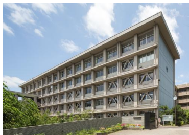
耐震改修された学校の例 (県立安芸高校校舎 H27年完成)
