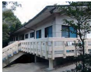
施設外観(本館)
