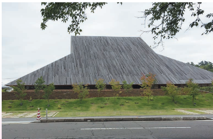
*直島ホールはWallpaper* Design Awards 2017でBest new public building部門最高賞を受賞するとともに、2017年日本建築学会賞作品賞も受賞しています。
