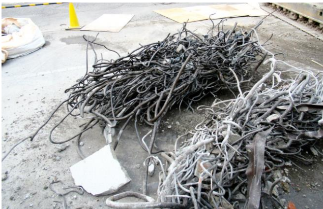
解体中に現れた大量の鉄骨
