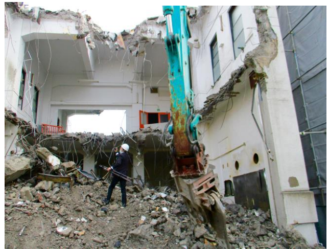
E.R.E 宇品御幸ビル解体中の様子 （平成 30 年 2 月 8 日撮影）
