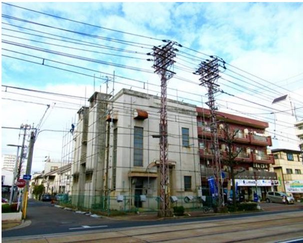
E.R.E 宇品御幸ビル解体前の全貌 （平成 30 年 2 月 3 日撮影, 解体のための足場が組んである状態）
