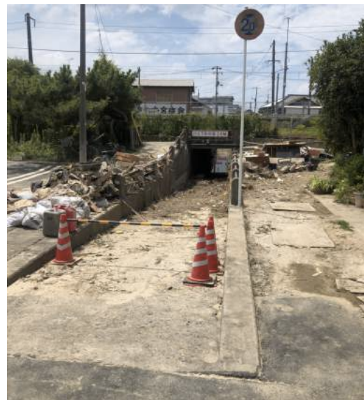
①-2 【安芸津】 被災状況
