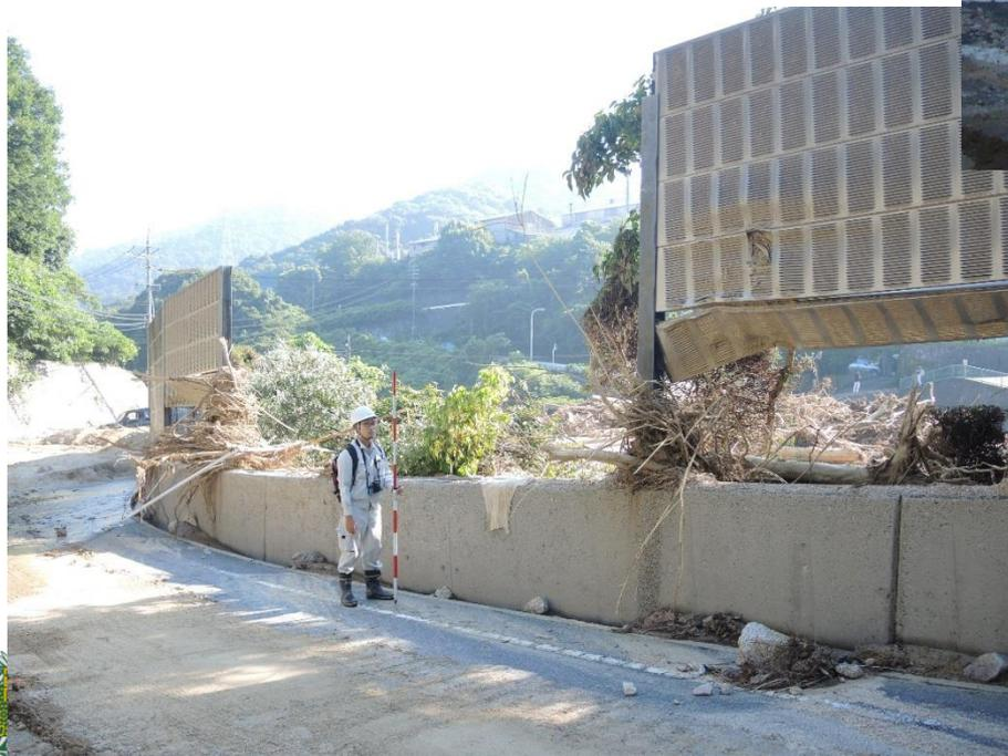
土石流が防音壁を破壊しているの
