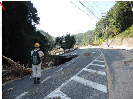
浅田病院方向の左側は川であり、吸い出されて陥没した路面。ガードレールは大きく川側に大きく変形。
