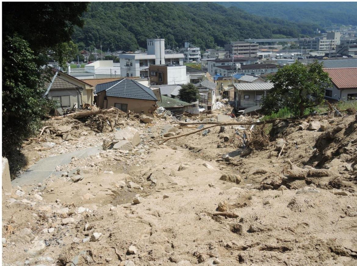
土石流は住宅に大きな被害を与えていた。幸い亡くなられた方はいなかったということであるが、広島県の過去の同程度の規模の土石流を考えると、人的被害が発生してもおかしくない規模の土石流であった。土石流の規模は5000m<sup>3</sup>以上と推定される。
