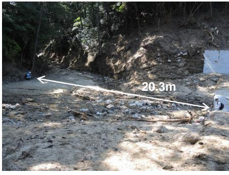
ダムの幅は約25.2m, 堆砂部の奥行きは 約20.3m, 堤体高さ8m. 平均的な堆砂 深さを4mと仮定すると2,000m3程度の土 砂が捕捉されたと見積もられるが、今回 はそれを超える量の土砂が発生したと推 察される.
