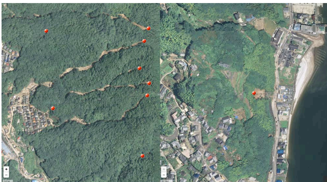
図2 斜面崩壊の種類（左：土石流（矢野東7丁目），右：崖崩れ（江田島市大柿町柿浦））
