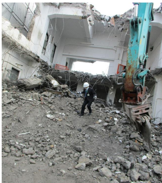
E・R・E 宇品御幸ビル解体現場における採取の様子（平成 30 年 2 月）
