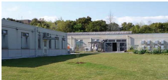
家畜環境制御実験棟
