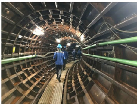
新設する水道管を入れるための トンネル内を現場点検中
