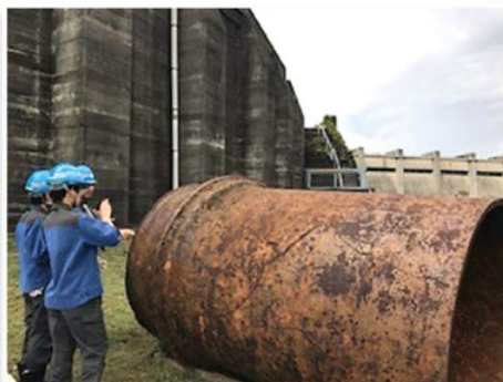
給水所現場点検の様子
