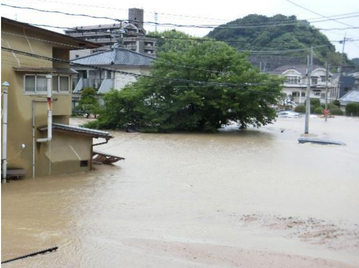
広島呉道路高架付近では1階がほぼ水没している（7/8撮影）
