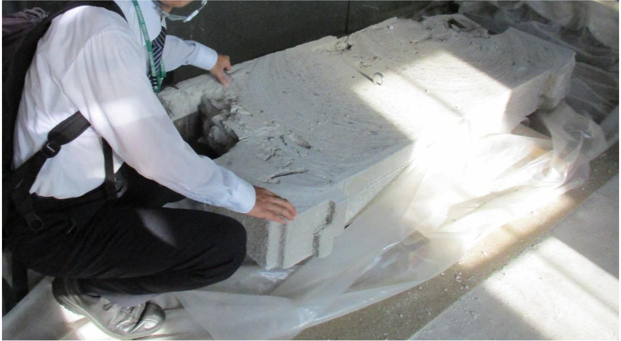
本通りに面した二階窓枠付近の壁材水平断材 153 cm×64 cm×18 cm、重量約 800 kg
