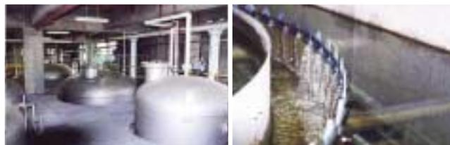
実験廃液処理水と洗浄水を処理している高度処理システム
