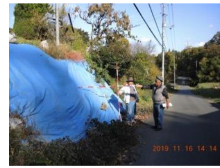
⑮畑のり面が崩れた
