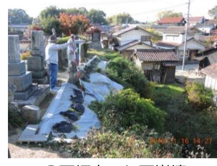
⑩西福寺のり面崩壊
