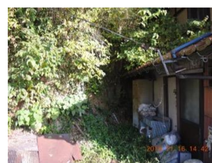
⑬この間から水が流出した
