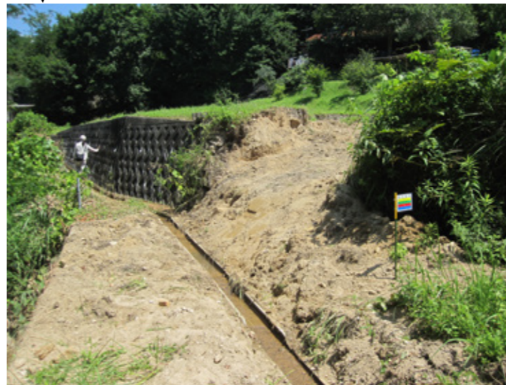
① 西条地区の法面の崩壊
