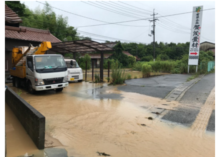
④ 吉行地区の道路の冠水
