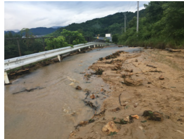
③ 高速道路側道の土砂の堆積
