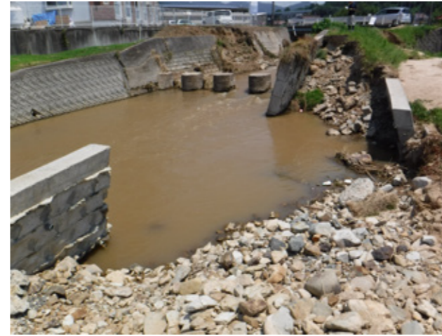
① 黒瀬川の堤防破壊
