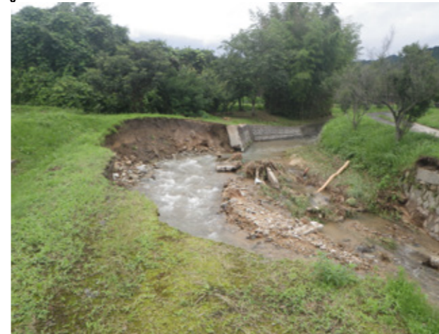
③ 亀岡地区の河川の堤防破壊
