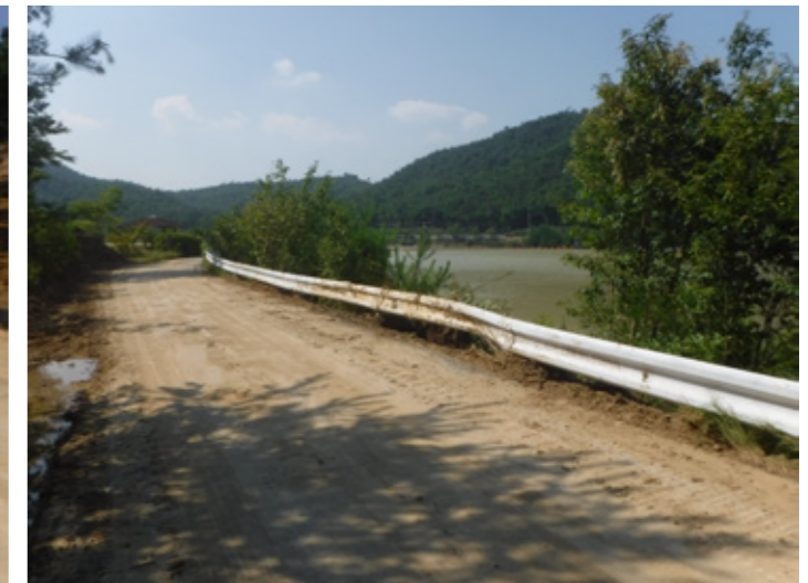
② 黒瀬ダム付近の土石流
