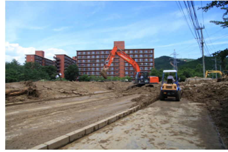
④ 乃美尾地区の土石流
