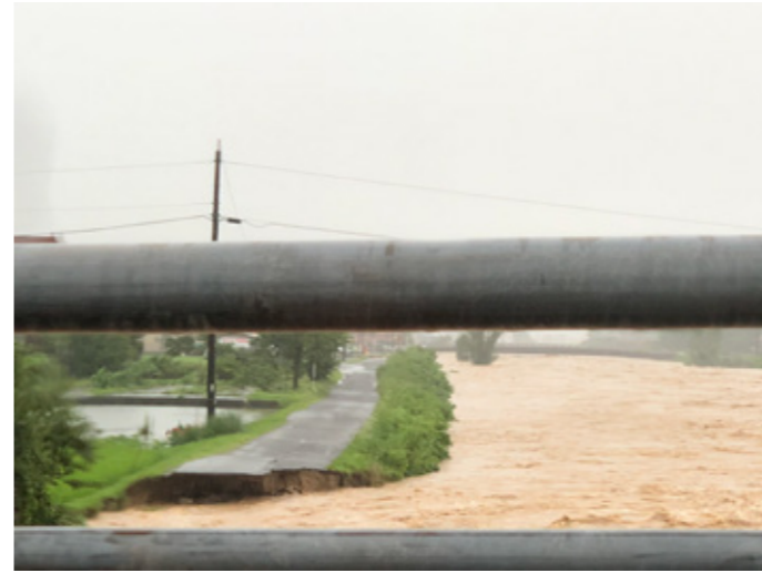
① 黒瀬川付近の堤防の破壊
