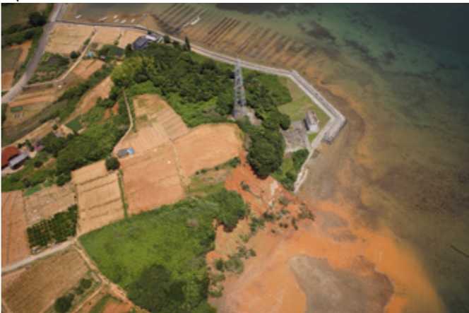
⑤ 二馬手地区の崖崩れ
