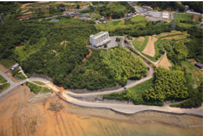
③ 本江地区の崖崩れ
