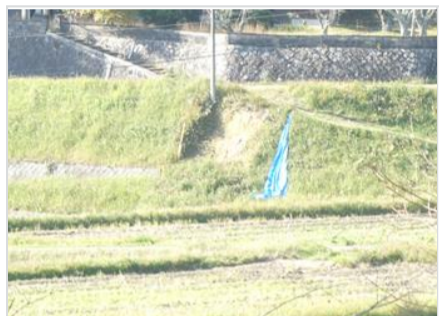
⑮常楽寺に通じる道が出水による畔崩落。また、道路にも亀裂が生じたため、早めの避難が必要
