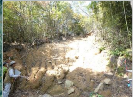
⑦斜面崩壊で下流に土砂流出
