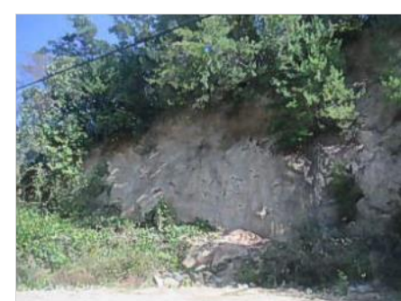
⑥西側から水が集水、一部崩落。下流に切子(水路分配施設)あり
