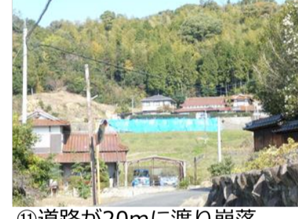
⑩道路が20mに渡り崩落。その道路を利用する住民は一時孤立状態となった
