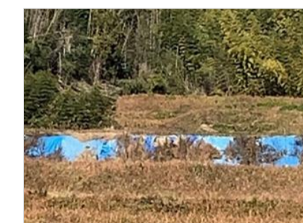
⑬山側から水が流出し、畔が崩落した
