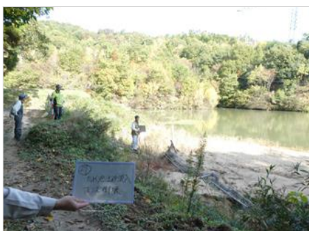
①2017年に大規模改修済。2018年豪雨時は土砂流入もフェンス破損のみ。破堤時は下流への影響大
