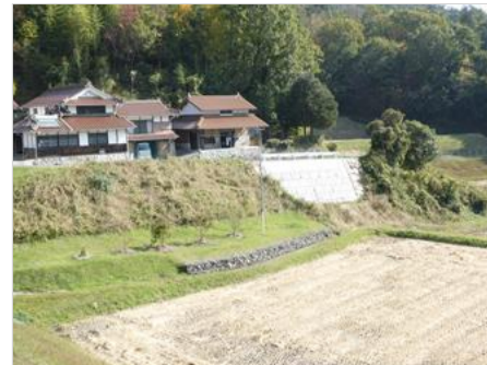
③土石流に流木が多数あり、一時ダム化。道路崩落
