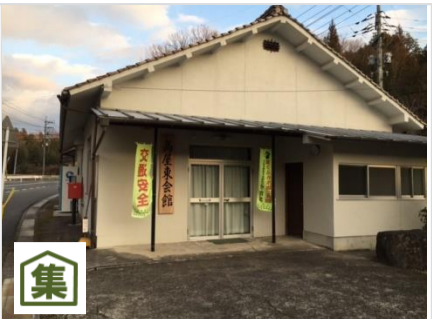
⑨ 高屋東会館 (北地区集会所) 集会所に水が集まる可能性がある
