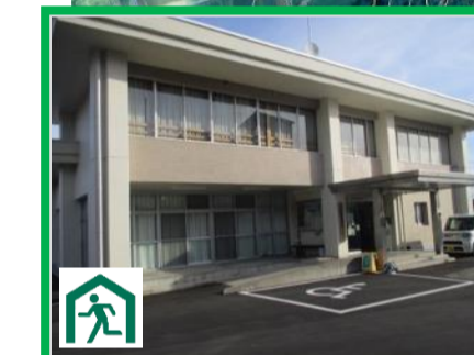
⑮ 高屋東地域センター 第一避難所
