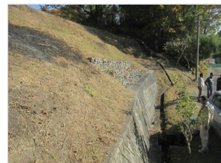
③ 溜池堤体修復状況
