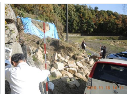
① 土石流により小屋が倒壊
