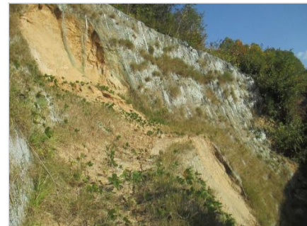
④ 住宅裏が崩落し避難した (2018年7月6日19時頃)
