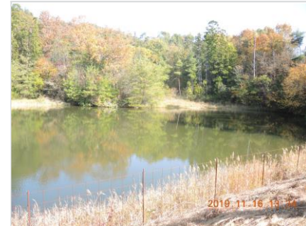
③ 過去に溜池が崩壊し復旧対策実施。豪雨時に土石流入・溢水に要注意
