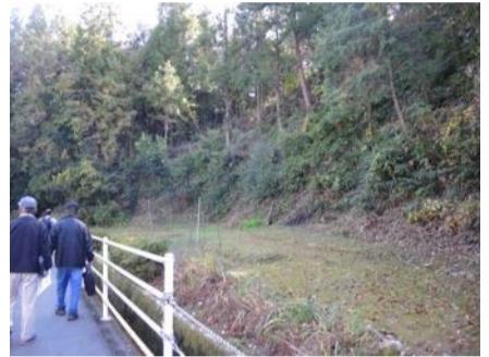
⑧山が崩れて水路をふさぐ可能性がある
