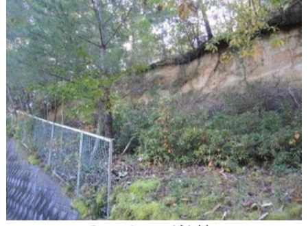
⑪のり面崩落の危険性あり
