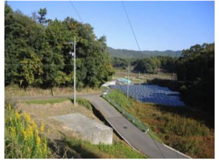
⑨水路に落ち葉がたまり水が溢れる
