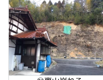
③④裏山崩れる
