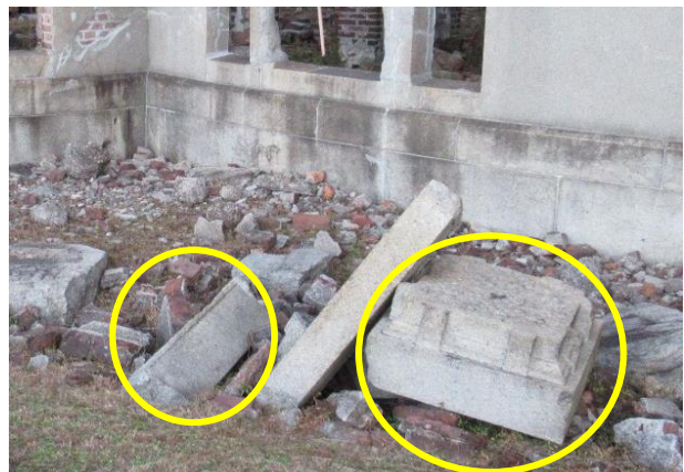
敷地内にある、落下した窓面台と門柱笠石
