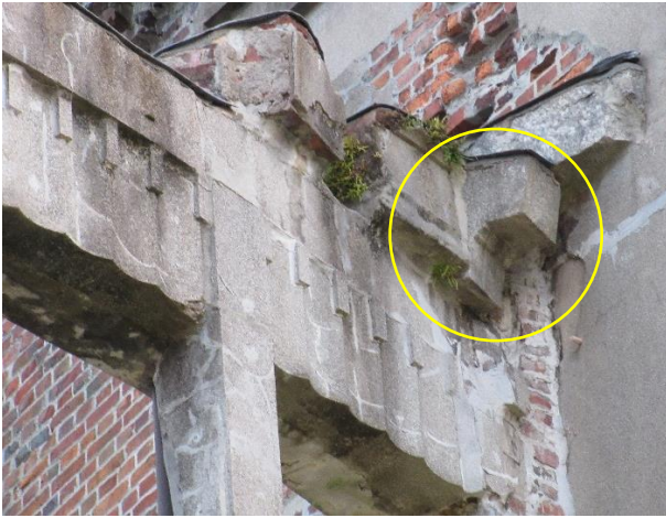
原爆ドームのデンティル（三階窓枠の上部）
