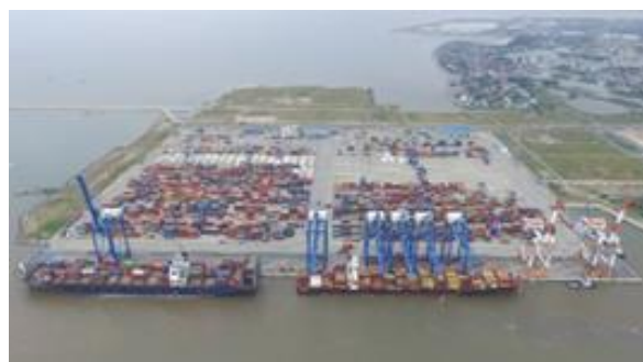
図3 運用開始されたラックフェン国際港
