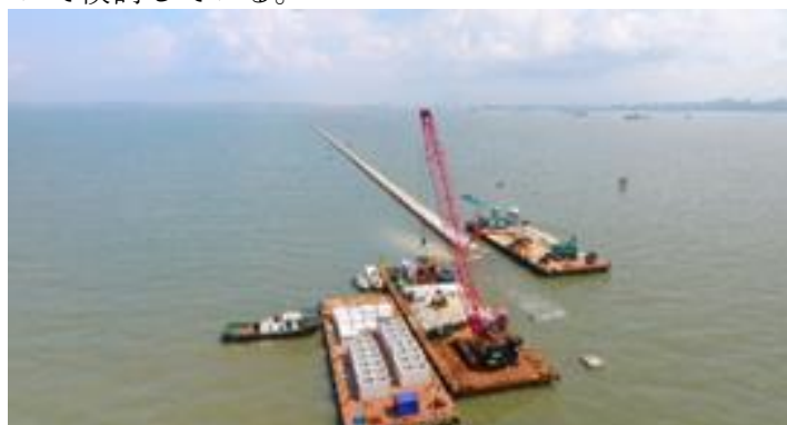
図4 防砂堤工事状況
