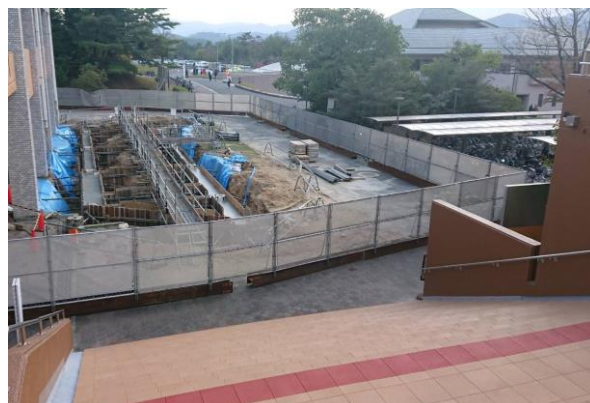
図2 東図書館横の工事現場
