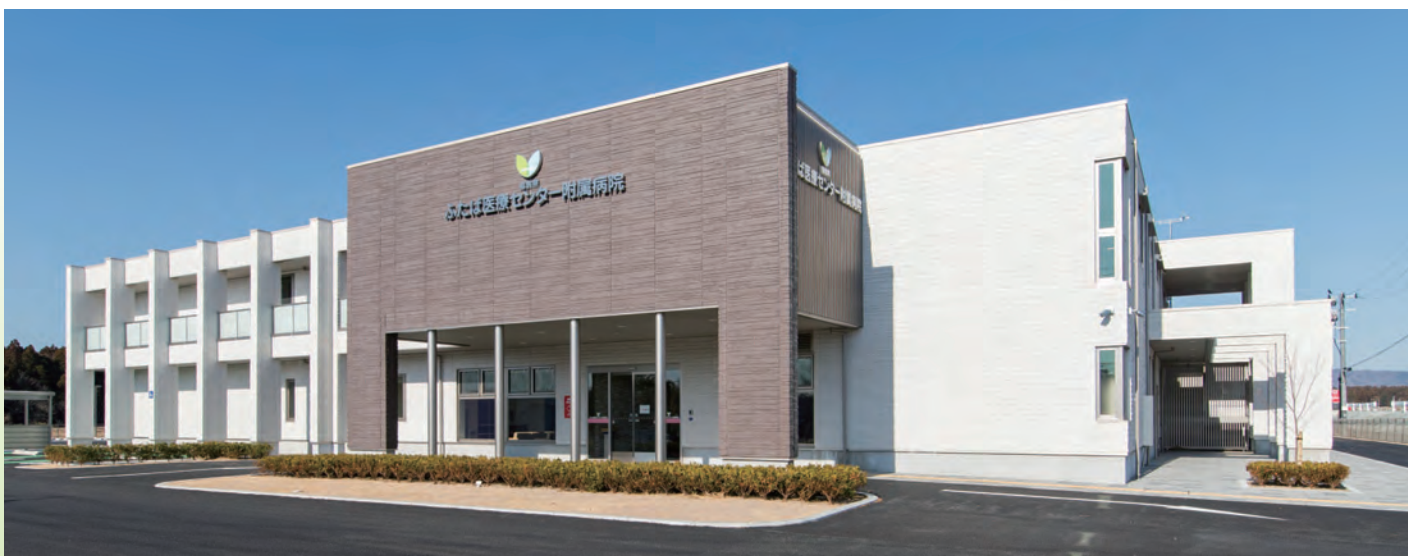
双葉地区に設置された「ふたば医療センター附属病院」の外観
