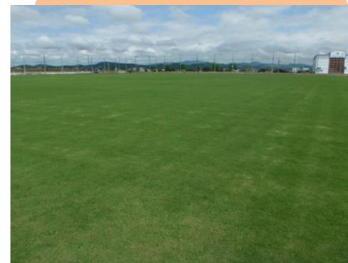
サッカーグラウンドの基盤と芝床の間にライトサンドを敷設。透水性と保水性が高まり、芝生の植生も良好
