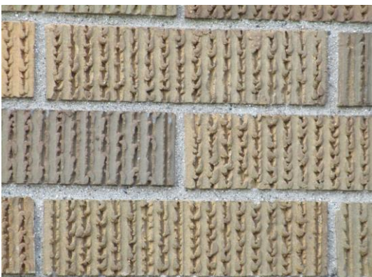
壁面のスクラッチタイル（建物南側）
