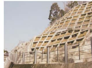
急傾斜地崩壊対策事業(東区戸坂惣田)
