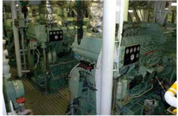
発電機関 / Engine for generator
