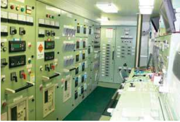
機関制御室 / Engine control room
