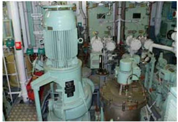
クラゲ除去装置 / Jellyfish removal system
