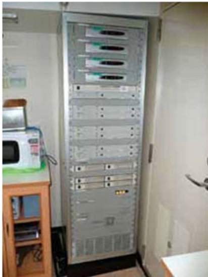
映像配信装置／Television image transmitter system
