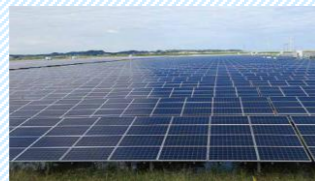
すべての屋上、駐車場に PV設置完了
