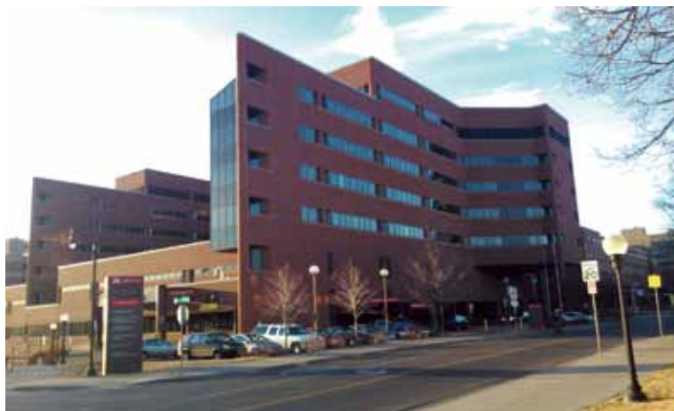
大学病院入院棟
