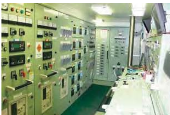
機関制御室 / Engine control room
