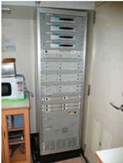
映像配信装置／Television image transmitter system
