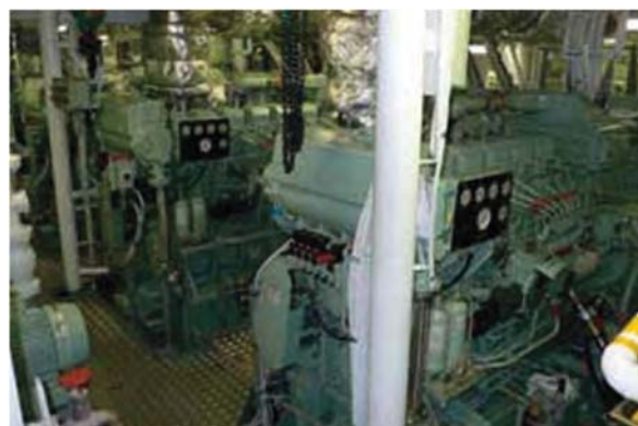
発電機関 / Engine for generator
