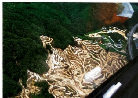
五日市ICと広島北ICの間 開発中の姿。人はどこまで侵入するのか? 山を削る規模は、自然より人工のほうがはるかに大きい。
