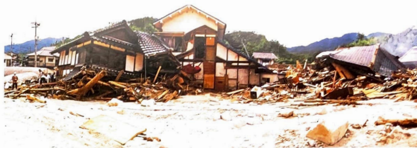
▲広島市佐伯区上小深川地区古野川 流木混ざりの土石流によって多くの家屋が全壊。この流域で2名の犠牲者が出た。
