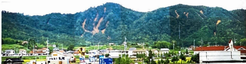
▲東広島市西条町助実 一見樹木に覆われた山も、豪雨があると根こそぎ崩れて土石流となっている。身近なところにも土石流災害の危険性が潜む。
