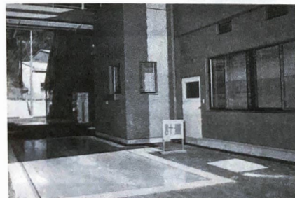
▲計量機（トラックスケール）
