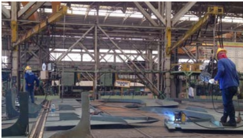
Figure 3 小組み立て工程
