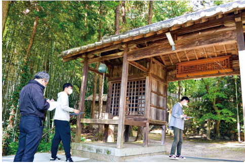
現地に赴き古建築物を調査
