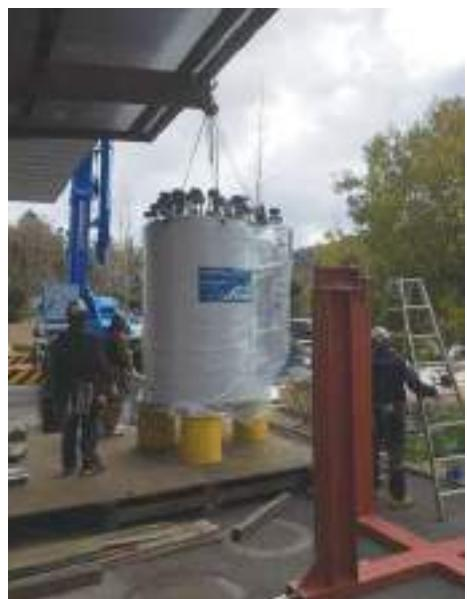
新しい液化機の搬入の様子。一度、黄色の台座に置くのは、トレーラーでの運搬の際、内部配管が振動しないように底に設置された振れ止めを外すため。
