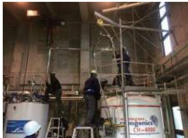
液化機と貯槽を繋ぐ、コの字型の真空三重管を挿入している様子。重量が 1 トン近い液化機と貯槽を 1 ミリ以下の精度で正確に据え付けなければ、絶対に三重管は入らない。しかし、今回は一度で成功させた。まさに職人芸である
